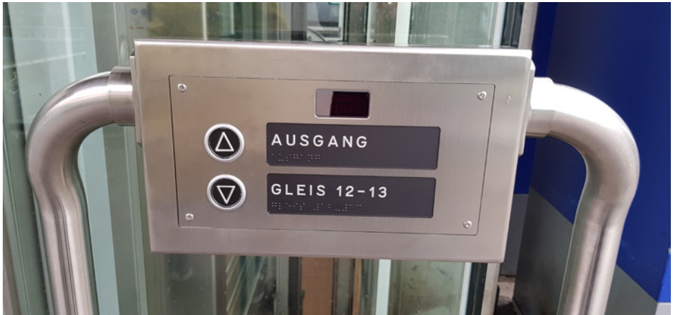
Relief- und Braille-Beschriftung auf einem Lift-Stockwerktableau
