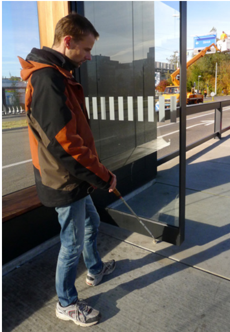
Markierte Glaswand, die nicht mit dem Langstock unterfahren werden kann
