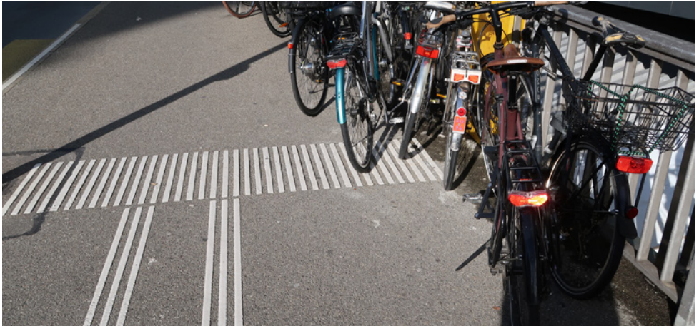
Bauliche Orientierungspunkte und taktil-visuelle Markierungen sind freizuhalten
