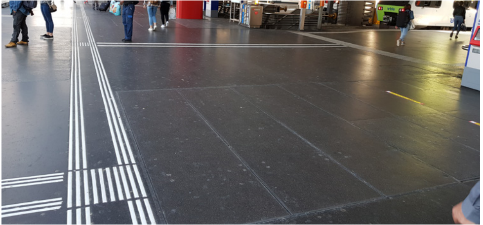
Weiträumige Gehfläche ohne bauliche Orientierungshilfe, mit taktil-visuellem Leitliniensystem
