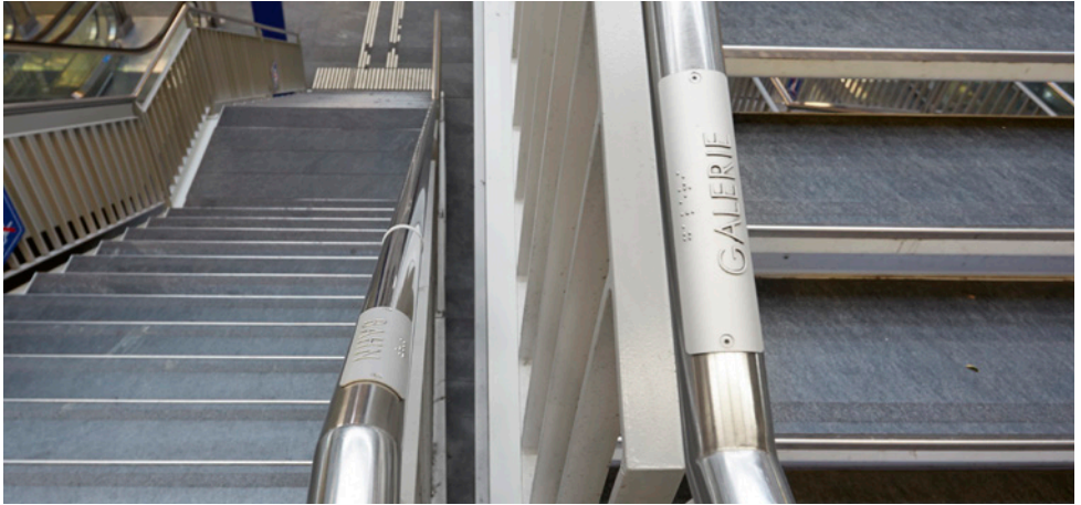
Relief- und Braille-Beschriftung auf einem Handlauf
