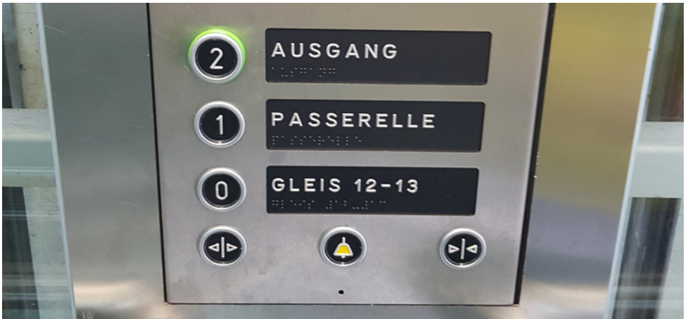
Relief- und Braille-Beschriftung auf einem Lift-Kabinentableau
