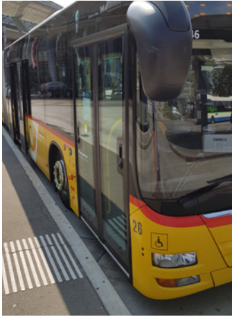
Champ indiquant le point d'embarquement aux arrêts de bus ou de tramway
