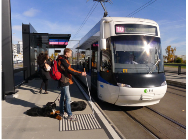
Champ indiquant le point d'embarquement aux arrêts de bus ou de tramway
