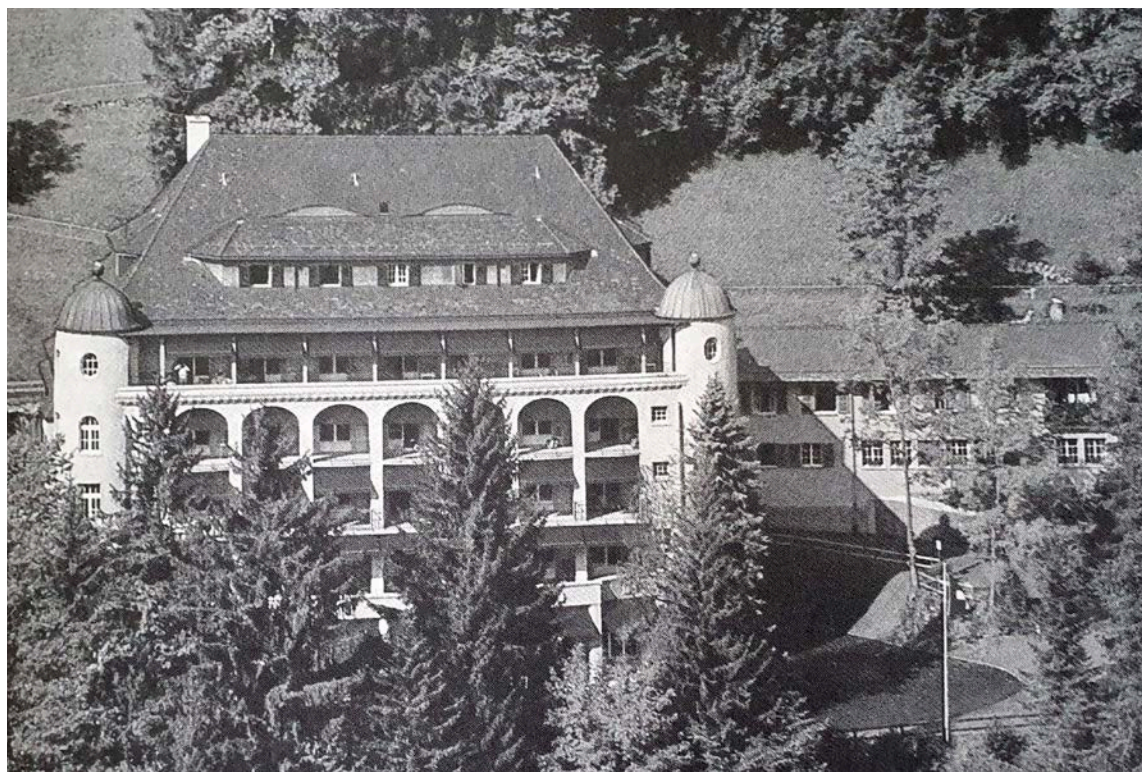
Solsana 1972 vor der Renovation
