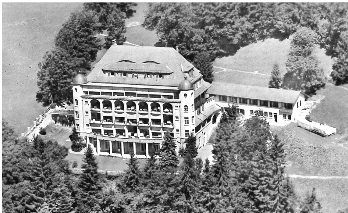
Solsana, 1994, après seize mois de rénovation et de transformation
