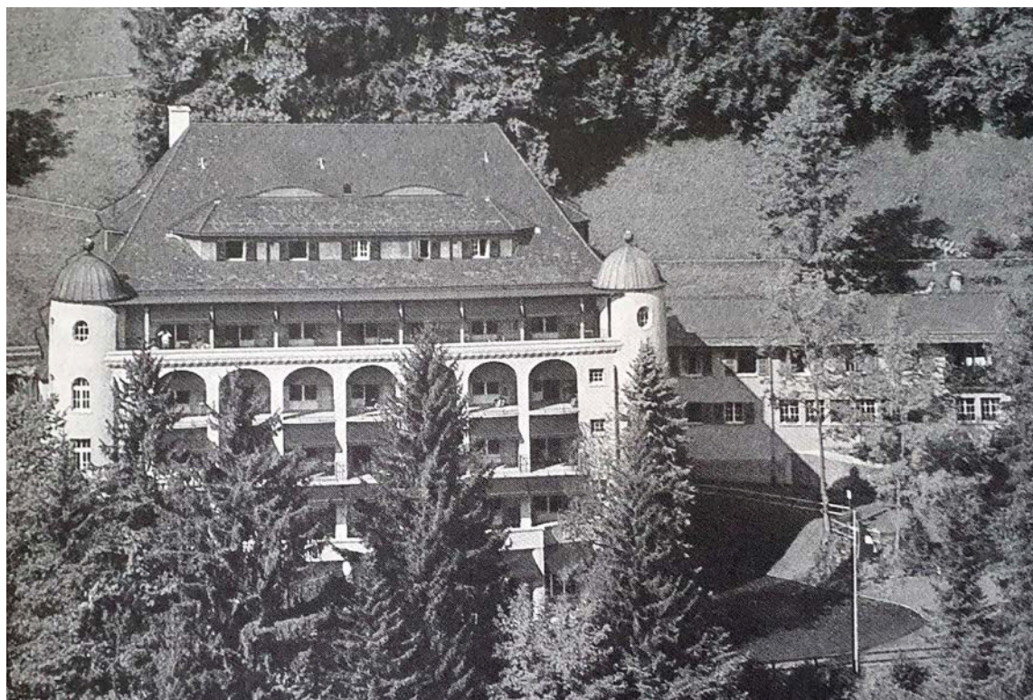
Le centre de vacances de Solsana en 1972, avant la rénovation
