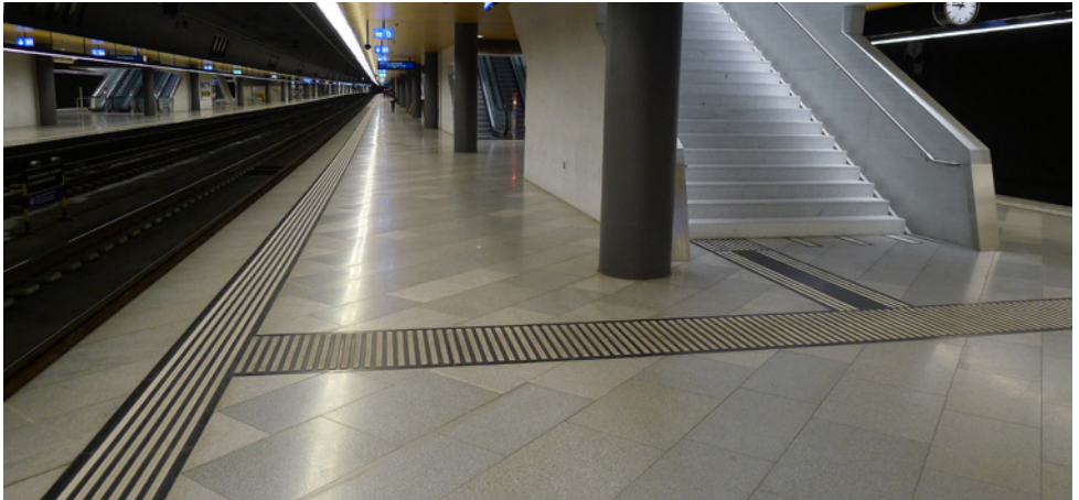
Bahnperron mit Sicherheitslinien und Perronabgangsmarkierung
