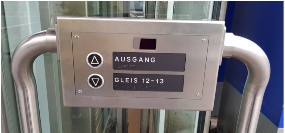
Relief- und Braille-Beschriftung auf einem Lift-Stockwerktableau
