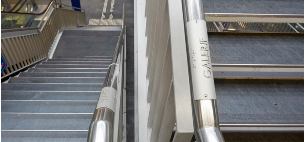
Relief- und Braille-Beschriftung auf einem Handlauf
