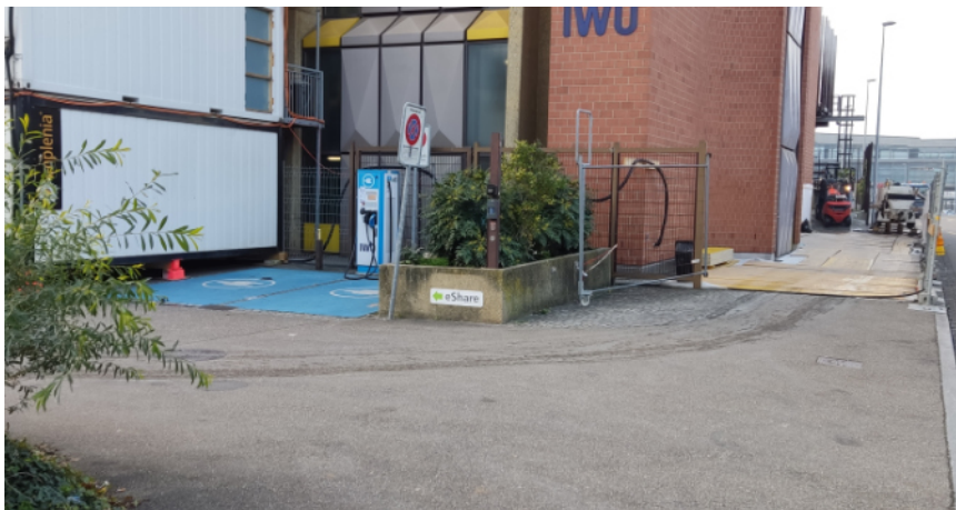
Heizwerk Bahnhof, Solothurnerstrasse 18, Basel
