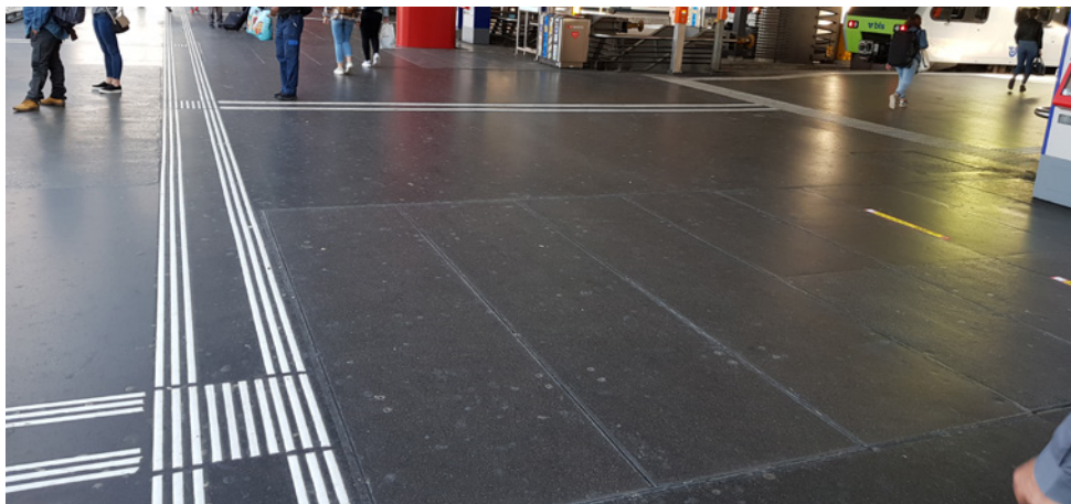
Large espace piétonnier sans aides structurelles à l'orientation, avec système de guidage tactilo-visuel
