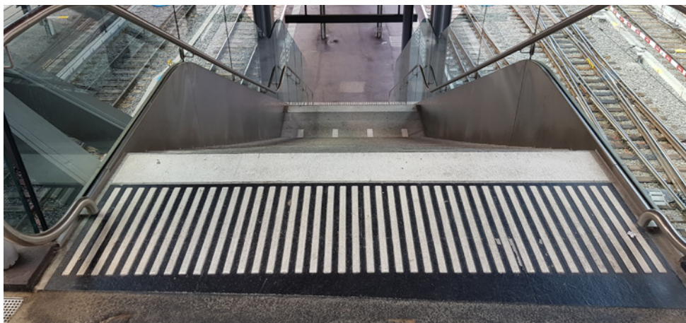
Descente/montée d'escalier avec marquages de début et palier intermédiaire (dents de pelle)
