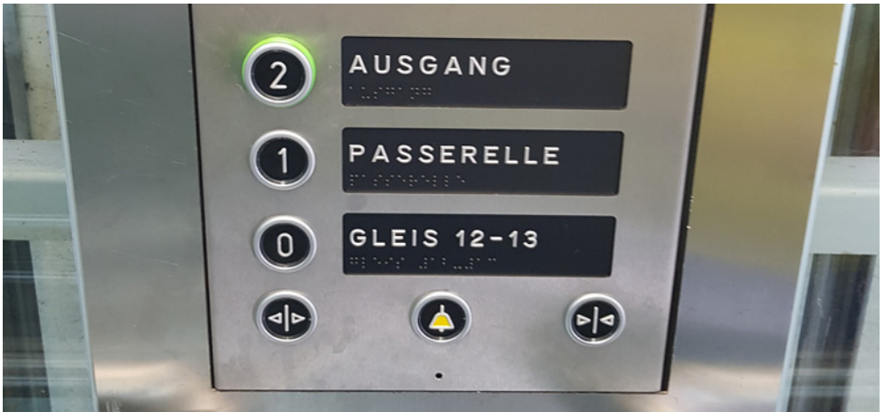
Inscriptions en relief et en braille sur le panneau de commande d'une cabine d'ascenseur
